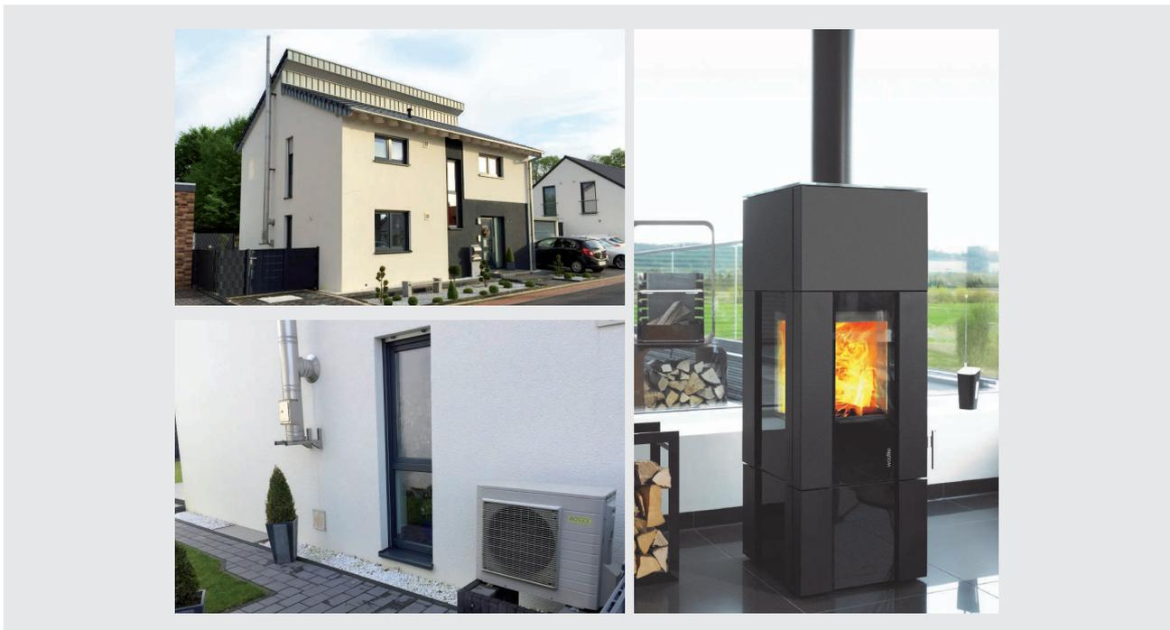
Abb. 8: Beispiel 1 – Luft-Wasser-Wärmepumpe und raumluftunabhängiger Kaminofen mit einer Abgasanlage aus Edelstahl an der Fassade
